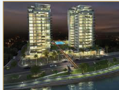
Οι Δίδυμοι Πύργοι (Olympic Residence)
